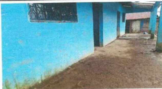
REPARACIÓN DE TORTA DE CORREDOR DE LA ESCUELA
