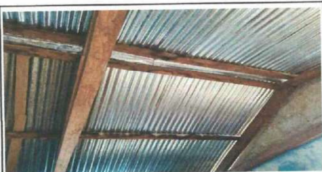
SUSTITUCIÓN DE VIGAS DE MADERA POR COSTANERAS
