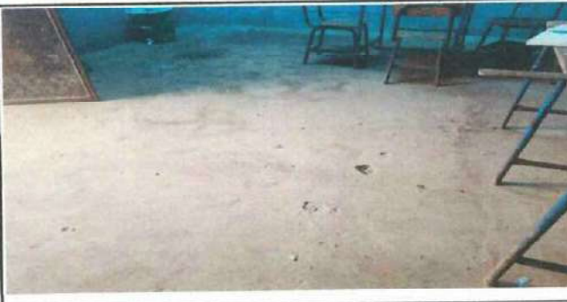
REPARACION DE TORTA DE AULAS
