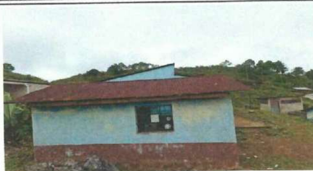
REPELLO DE PARED Y SUSTITUCIÓN DE VENTANAS Y PINTURA DE MUROS DE EXTERIORES E INTERIORES
